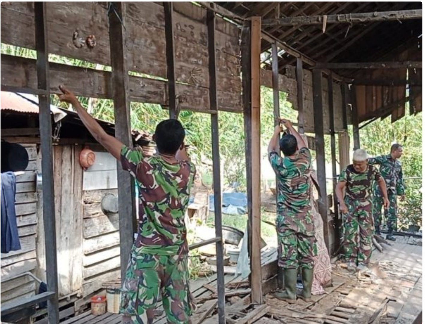
Hari ke Dua Bantuan Rehab RTLH Kodim 1006/Bjr, Bangun Tiang dan Rangka Rumah
