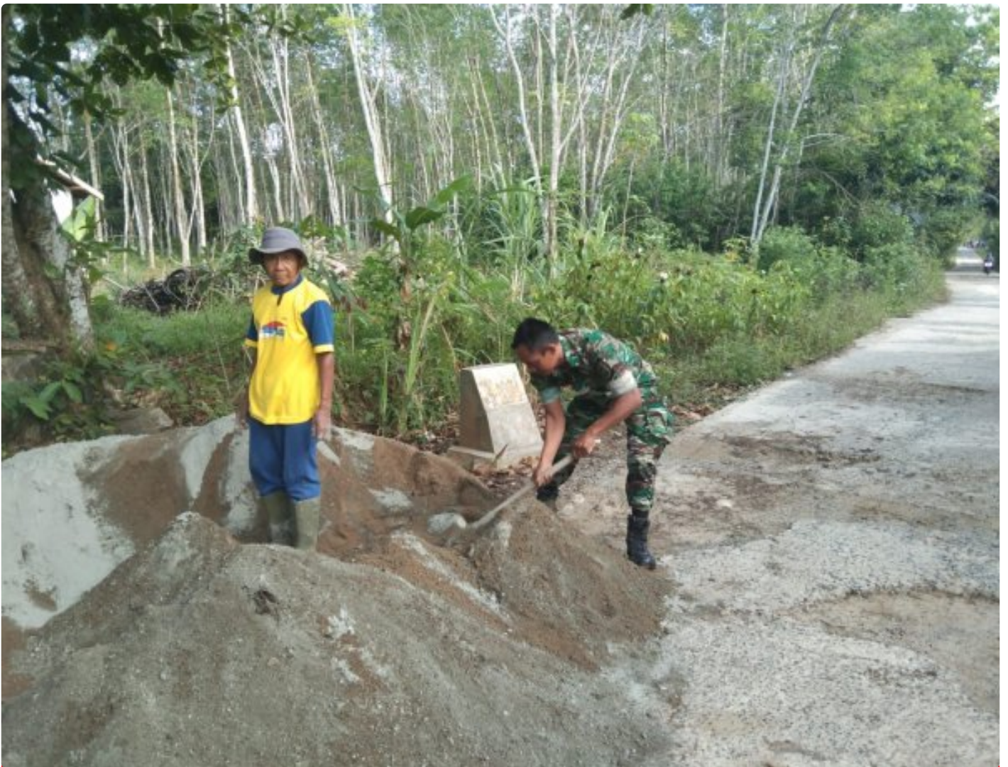
Babinsa Bantu Gotong Royong Pengecoran Jalan
